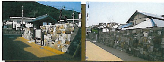
①武家屋敷通りに復旧された武家門と石塀
